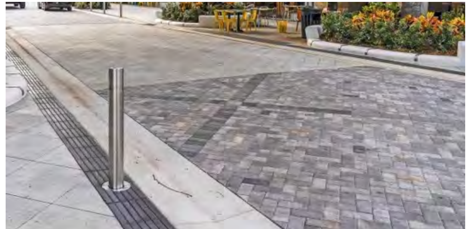
Bolardos retráctiles en Clematis St., una calle flexible en West Palm Beach, Florida
