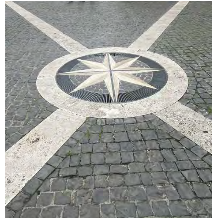
El material de la calle debe continuar a través de las intersecciones y presentar una variedad de diseños geométricos. El diseño táctico puede ayudar a reducir la velocidad del tráfico transversal.
