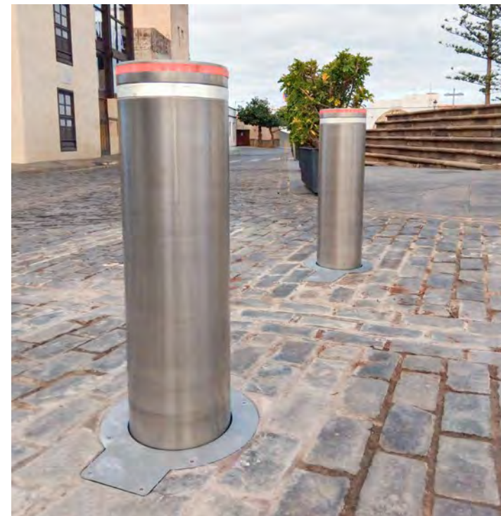
Detalle de un bolaro retráctil automático.
