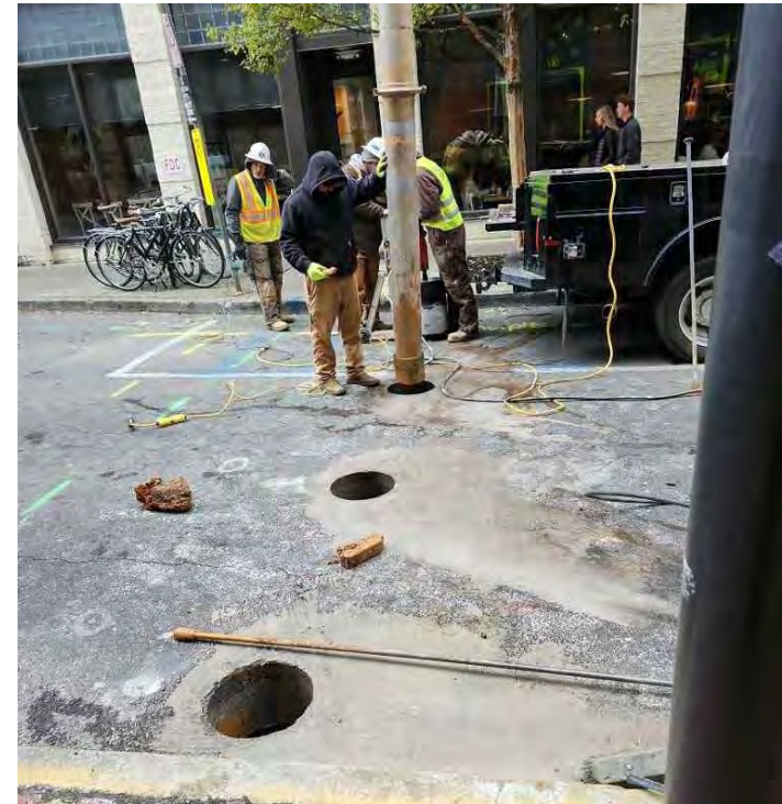
Proceso de instalación de bolardos en Knoxville, Tennessee.
